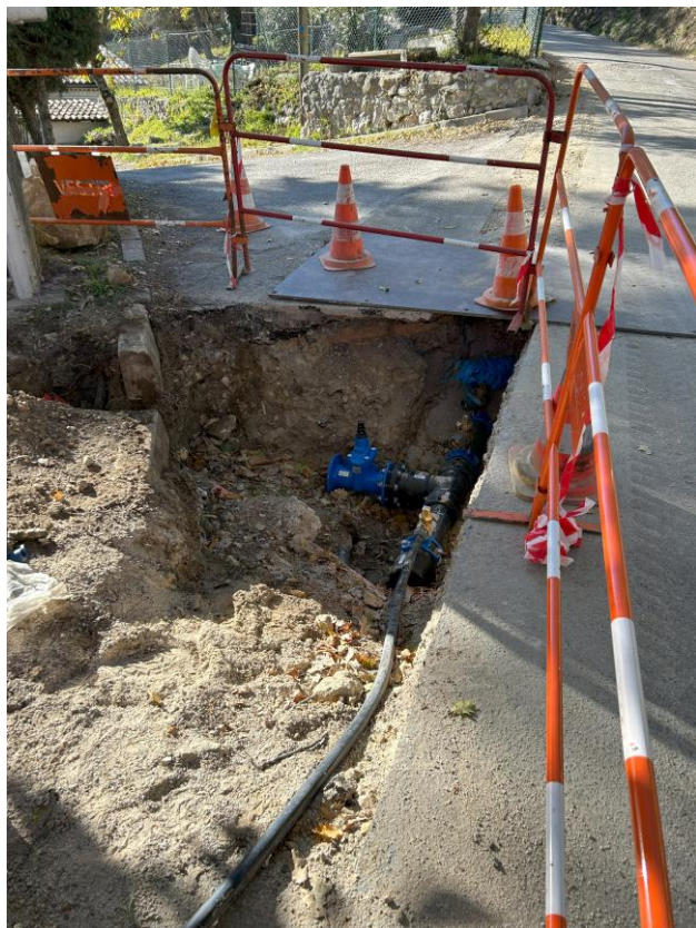
Bouyon – Route de l'Adrech - Renouvellement de réseau fuyard sur 308 ml
