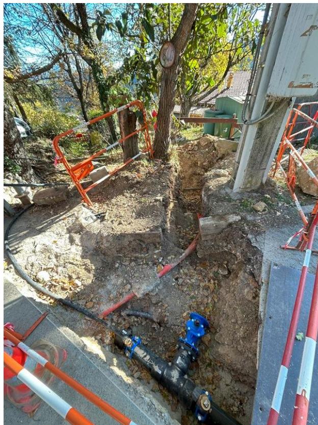
Bouyon – Route de l'Adrech - Renouvellement de réseau fuyard sur 308 ml
