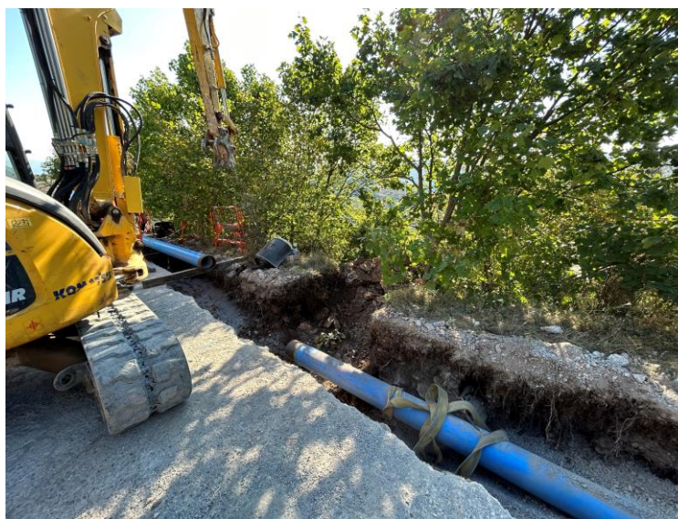
Bezaudun-les Alpes – Chemin de la Feubies Est Renouvellement de réseau fuyard sur 525 ml
