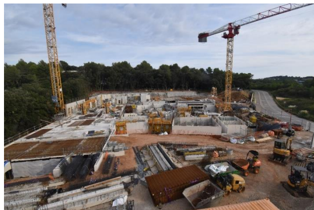
Chantier du pôle innovation – septembre 2024
