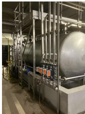
Mise en place du traitement interne de l'hydrogène Sulfuré
