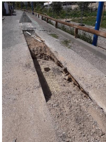
Voies De Gaulle / Montferran VILLENEUVE LOUBET
