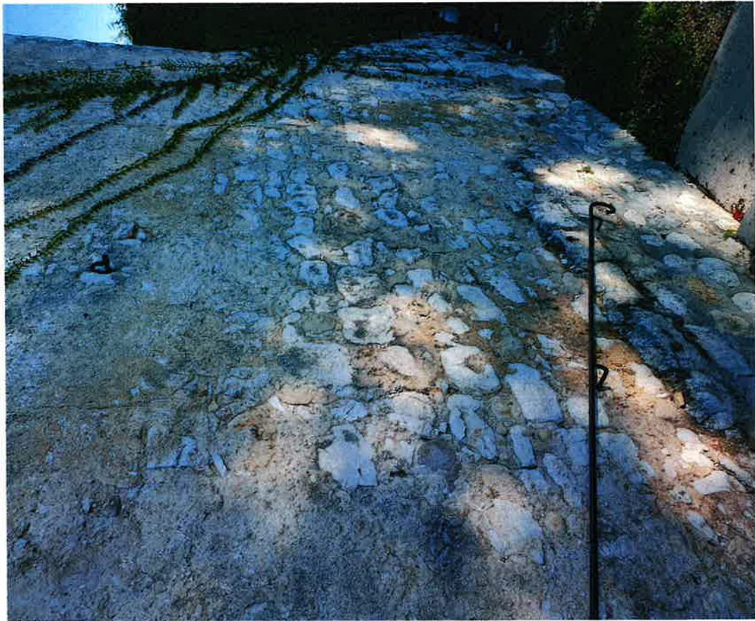
Fig. 16 Vue sur le mur de soutènement de la façade sud Maçonneries endommagées en tige creusée
