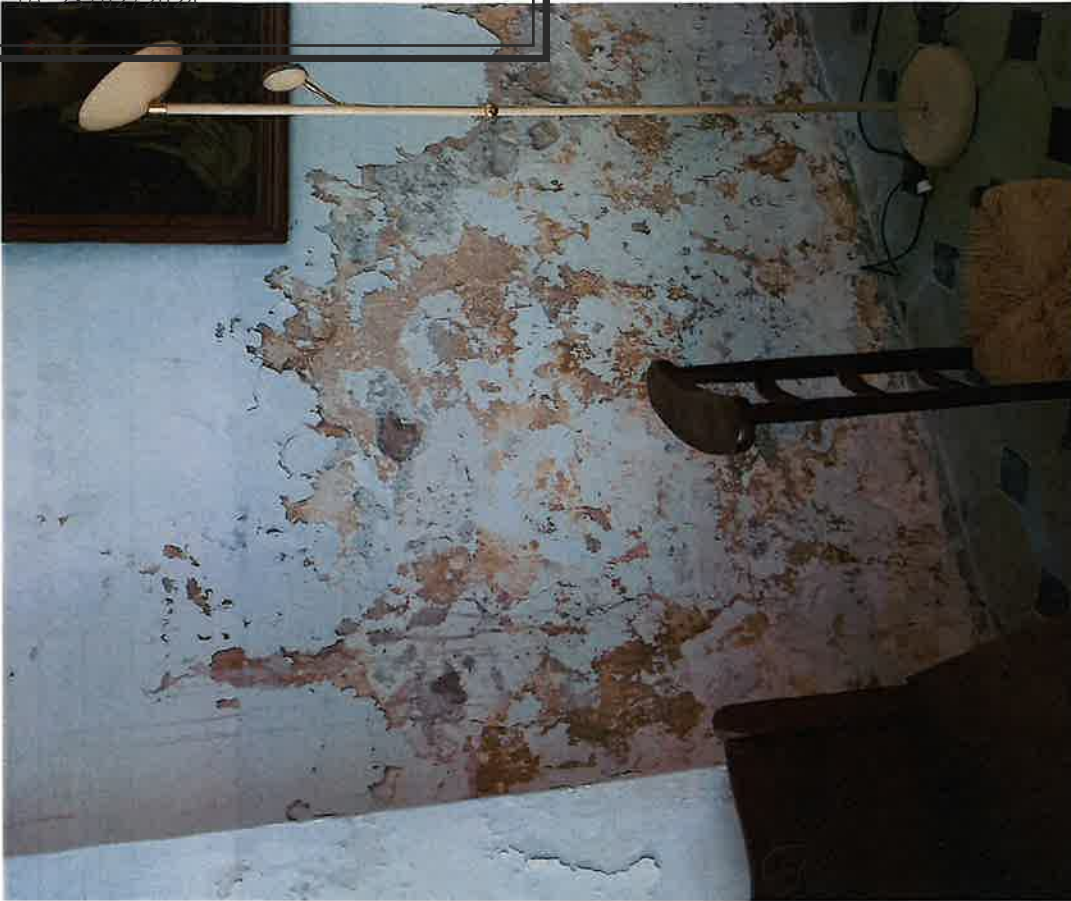
Fig. 17 Enduit abîmé sur le mur latéral est du chœur
