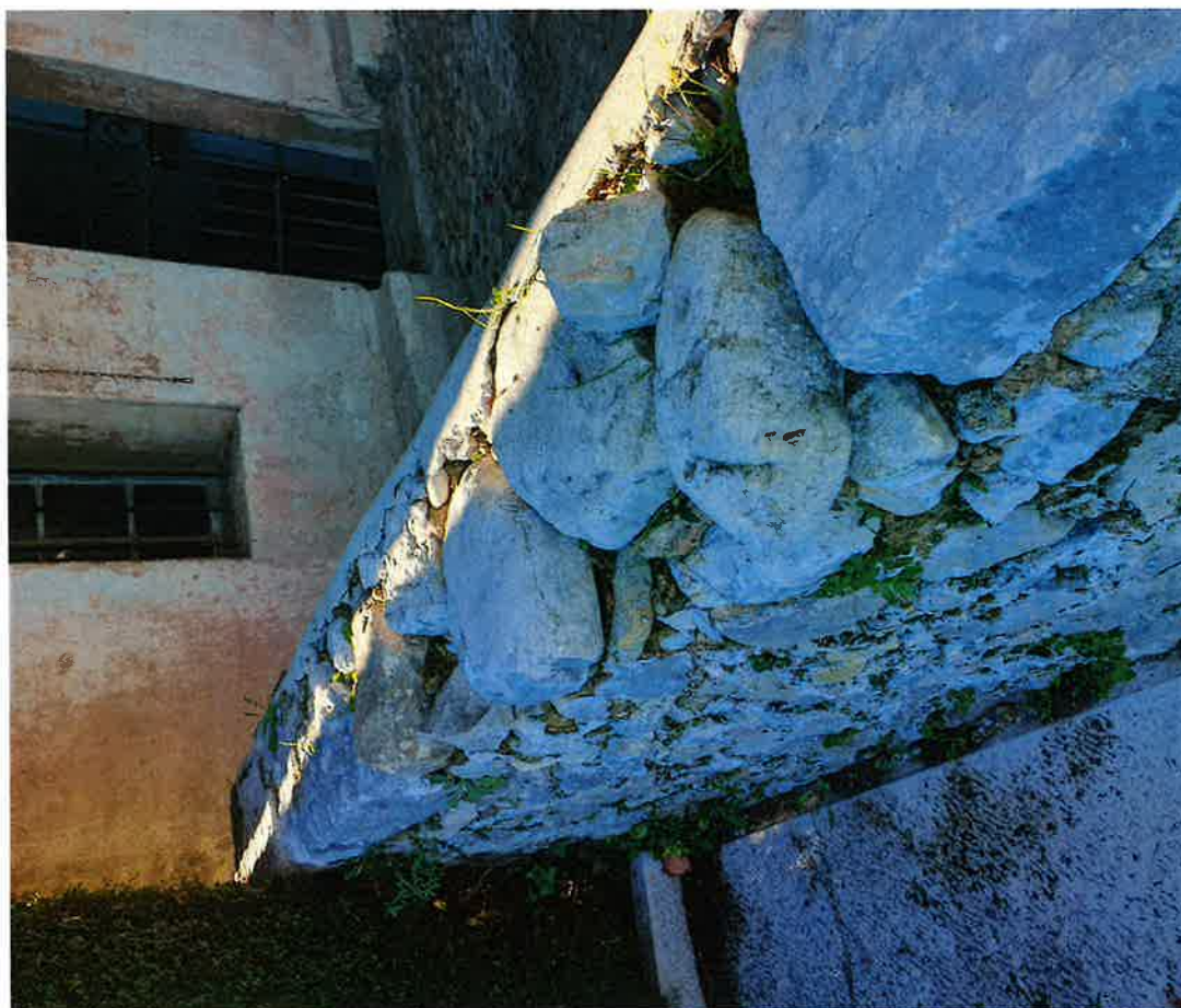
Fig. 16 Pierres manquantes ou à réassembler sur le muret est du porche
