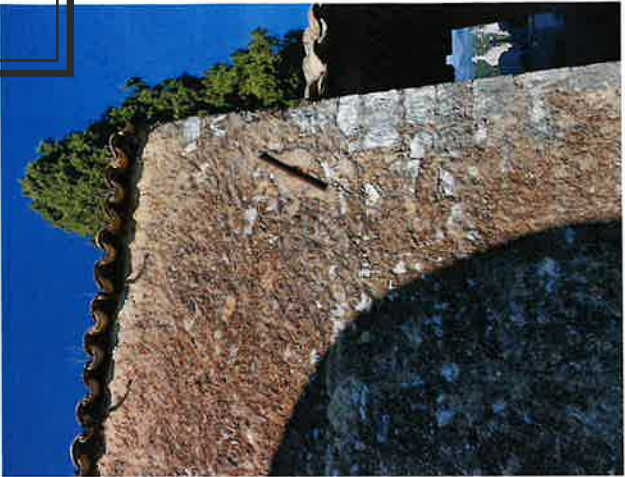
Fig. 37 Vue sur la chaîne d'angle en pierre de Cassis du mur gouttereau est de la chapelle.
