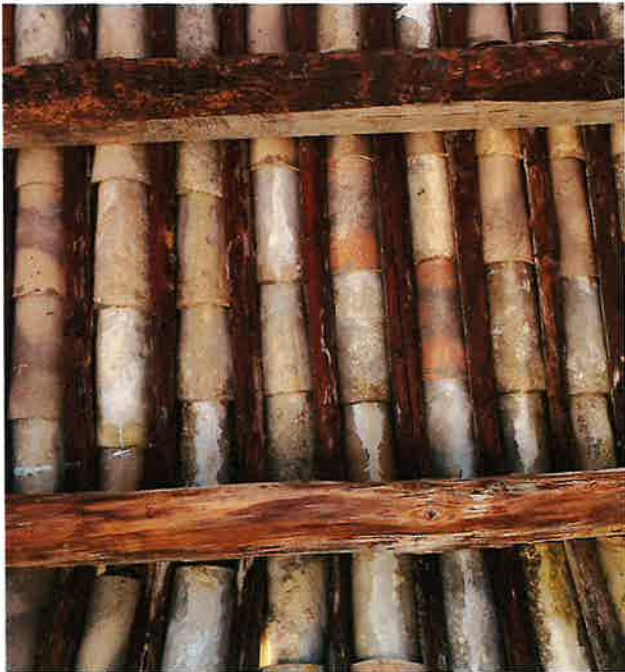
Fig. 36 Vue sur la charpente sous l'auvent avec la panne faîtière à gauche et une panne intermédiaire à droite
