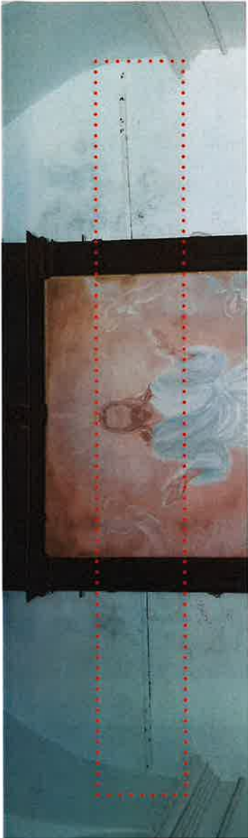
Fig. 34 Tirant courant sur toute la largeur du chevet et derrière le retable Tirant encadré en rouge ci-dessus
