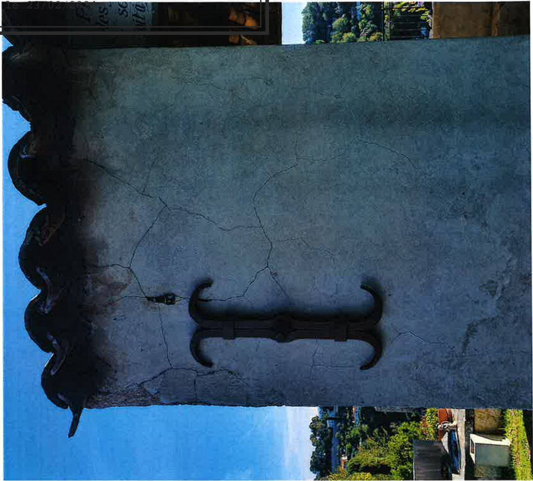
Fig. 17 Ancrage mur extérieur porche
