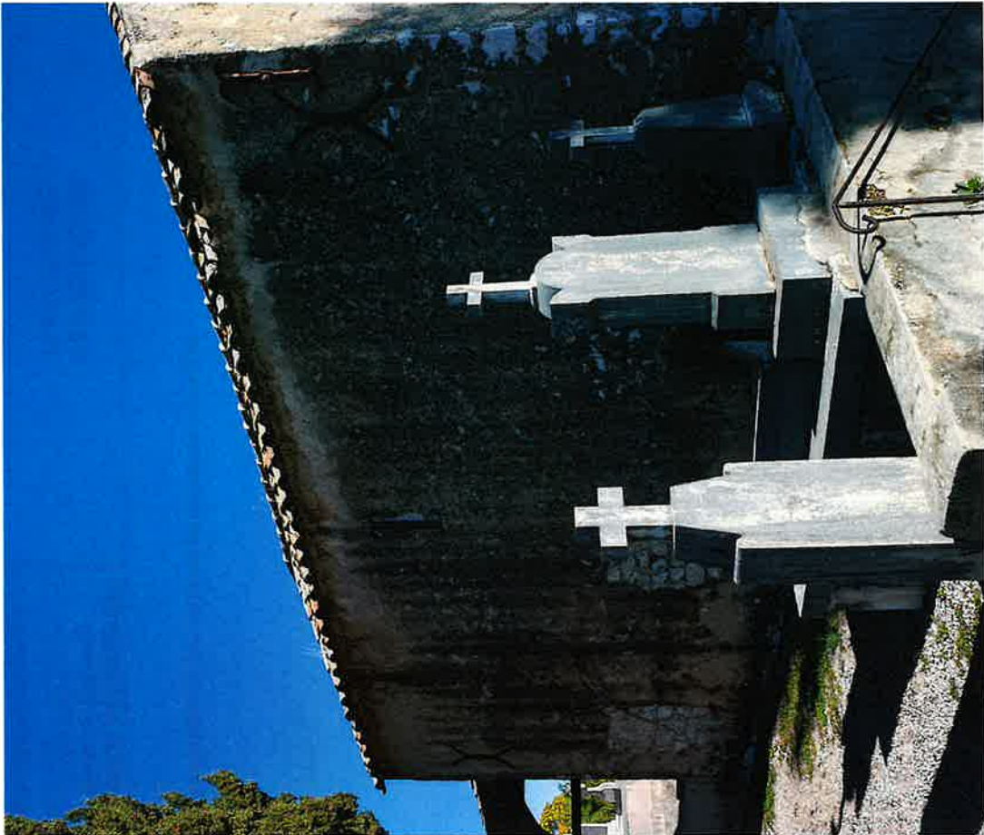
Fig. 16 Mur gouttereau ouest sale et tuiles manquantes tuiles manquantes encadrées en blanc ci-dessus
