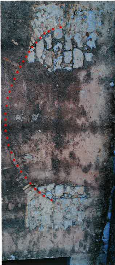
Fig. 35 Arc visible sur l'élévation ouest Cintre souligné en rouge ci-dessus
