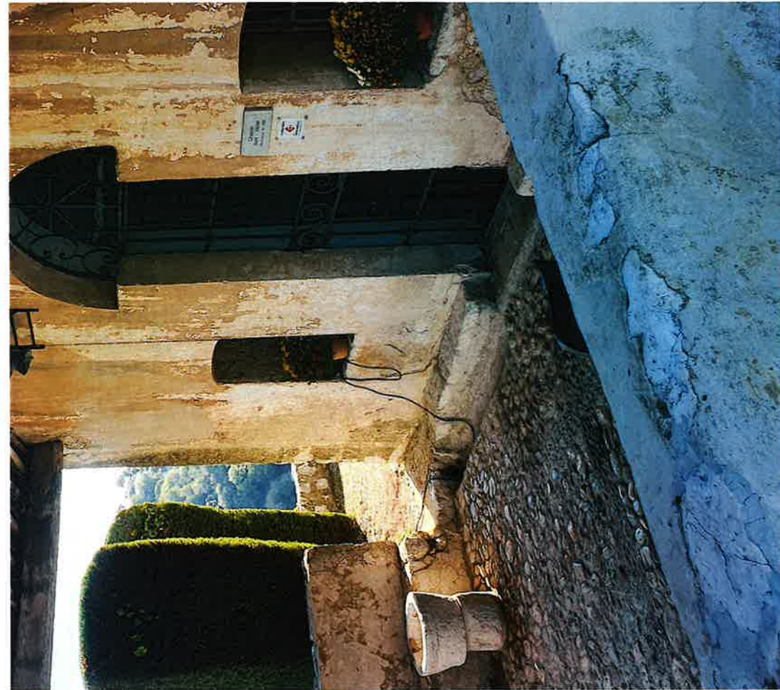
Fig. 17 Surface du banc ouest sous le porche avec absence d'enduit par endroits
