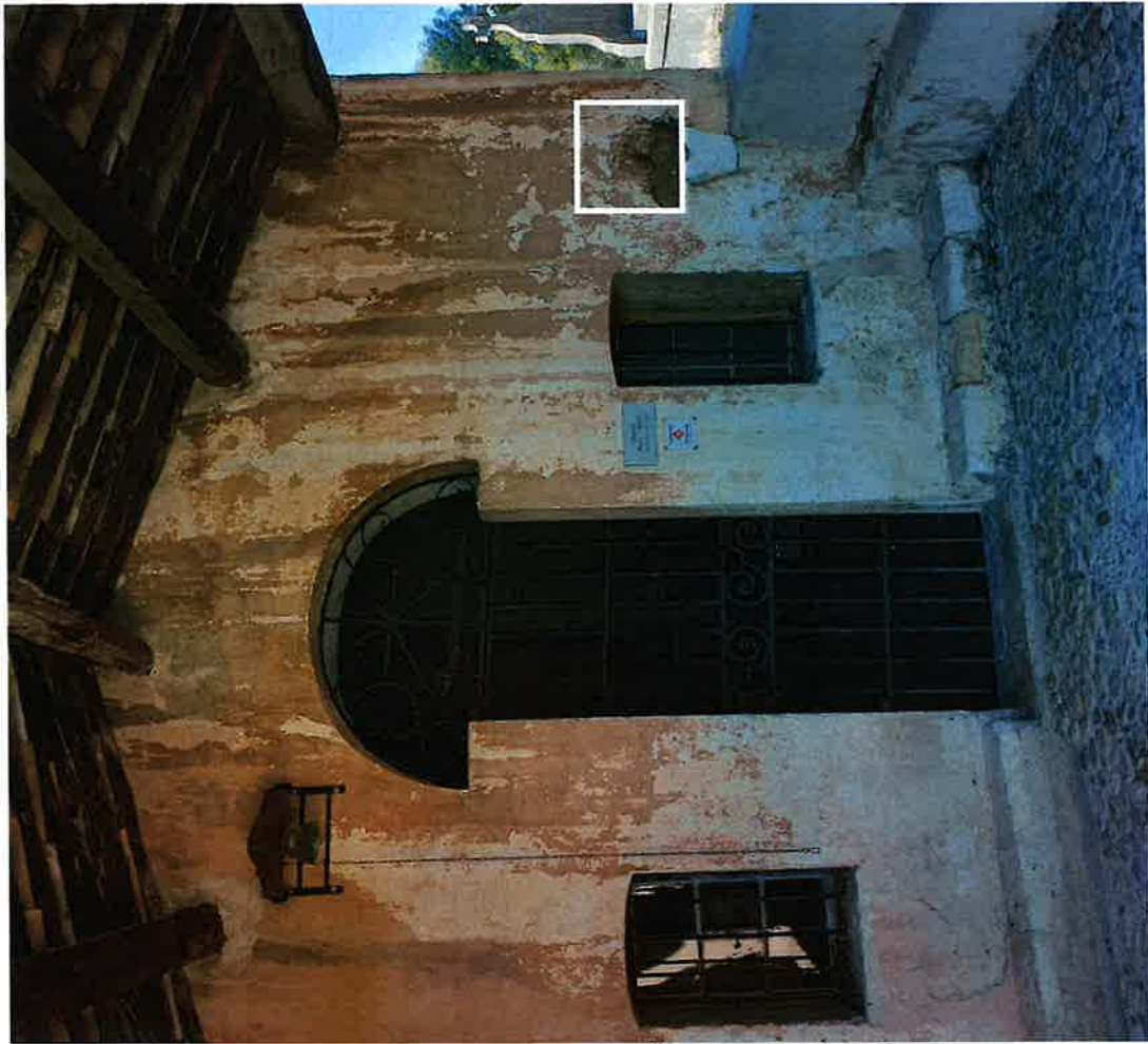
Fig. 16 Badigeon altéré sur la façade de l'entrée de la chapelle close et pierre manquante au dessus du bénitier Pierre manquante encadrée en blanc ci-dessus
