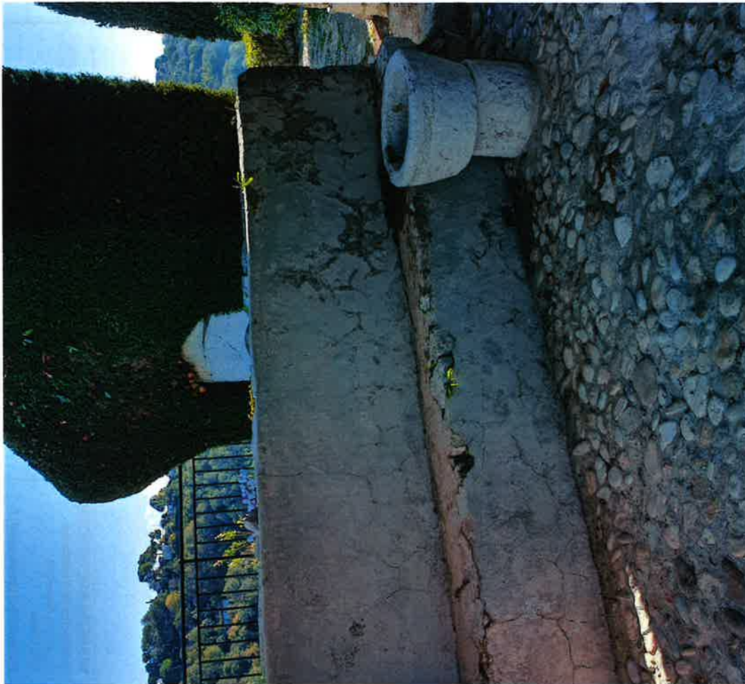
Fig. 16 Banc en pierre détérioré sous l'auvent
