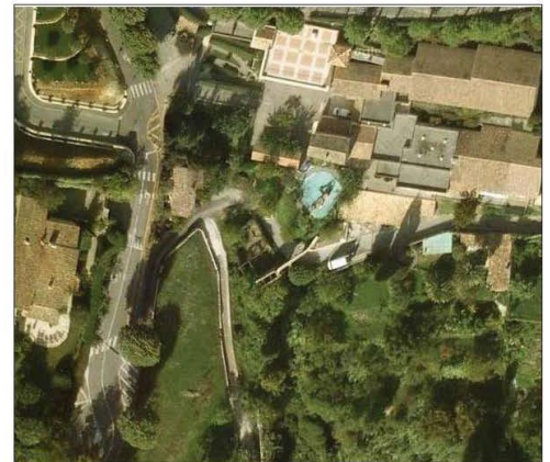
Photo aérienne (Source IGN)
