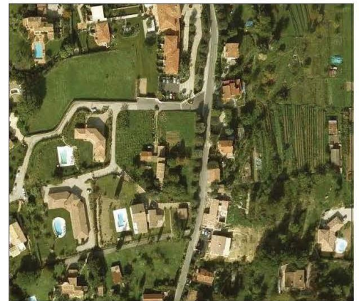
Photo aérienne (Source IGN)
