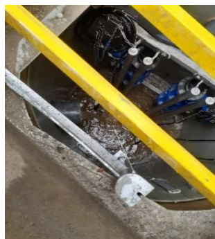
Création d'un réseau et d'un poste de relevage Av. G. Clémenceau VALLAURIS
