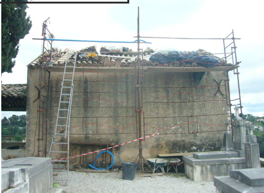
Dépose de la couverture existante
