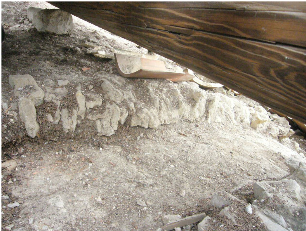
Nettoyage de l'extrados de la voûte
