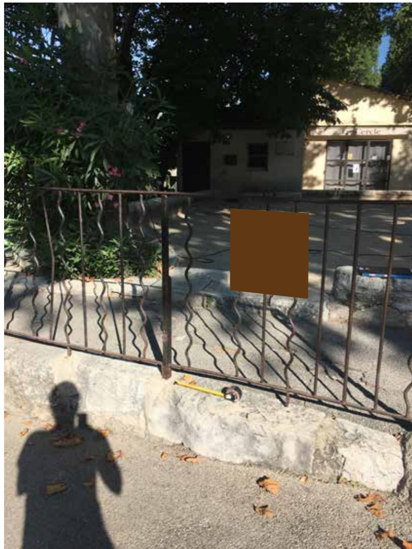
Montage sur barreaudage avec contre-plaques arrières
