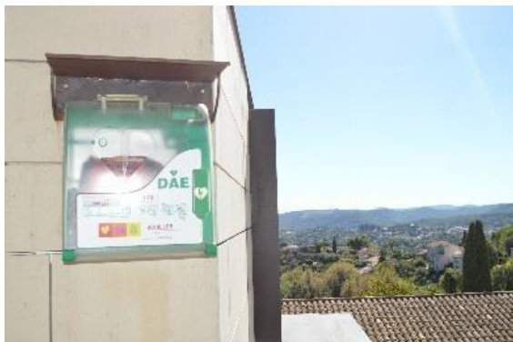
Entrée de l'auditorium, Route des Serres
